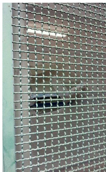
tela danificada cozinha
