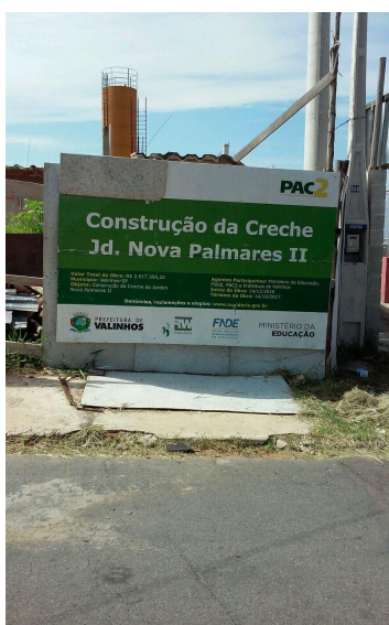
placa de identificação da obra
