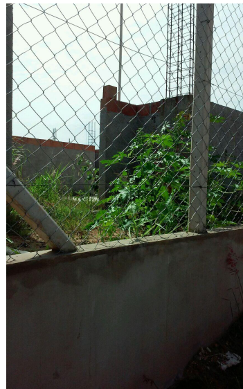
estado. da obra
