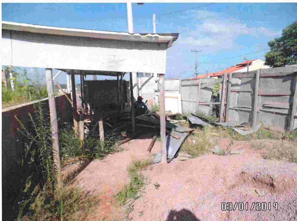
Limpeza da obra - Canteiro
