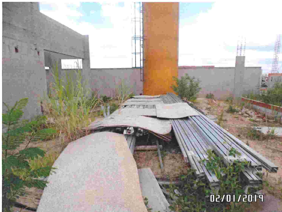
Estrutura da cobertura e a caixa d'água
