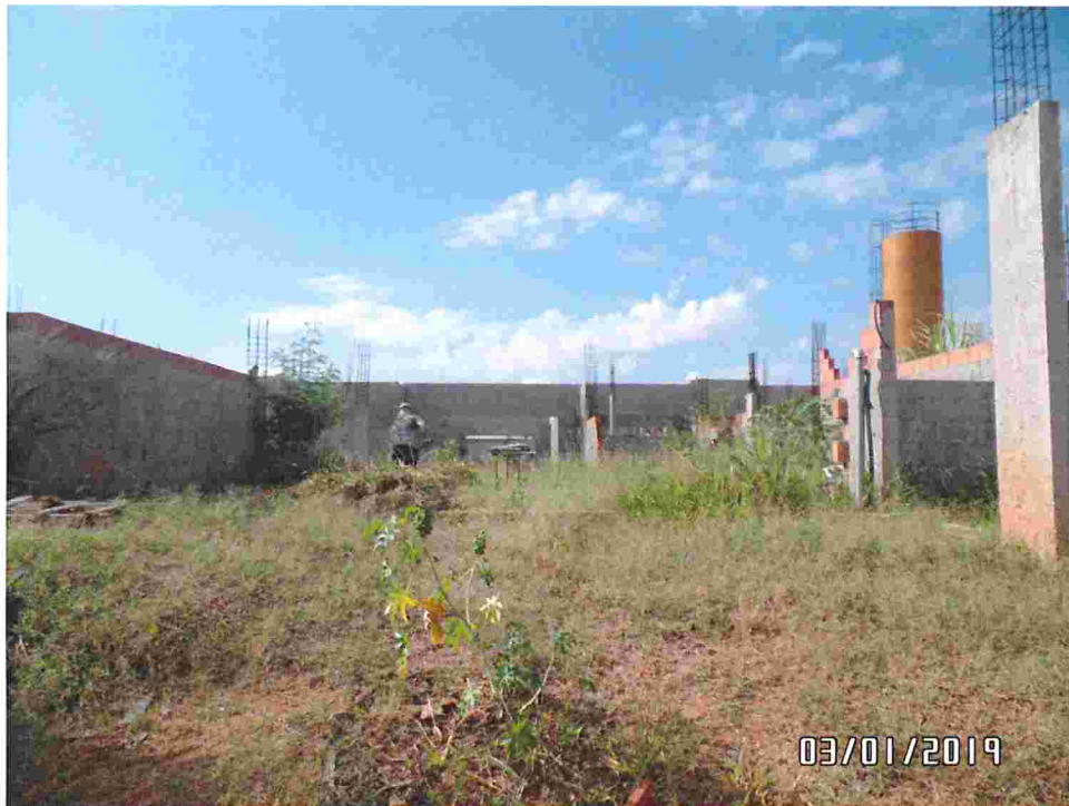
Limpeza da obra
