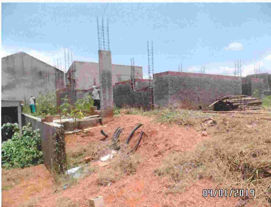
Limpeza da obra
