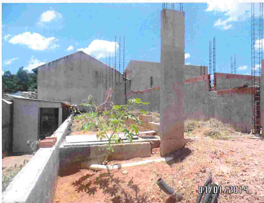
Limpeza da obra
