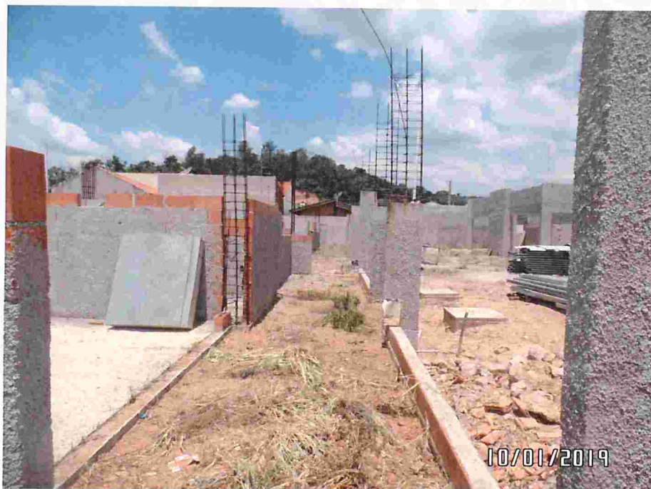
Finalizando a limpeza da obra
