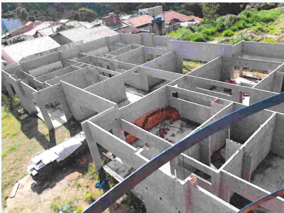
Vista de cima da caixa d'água
