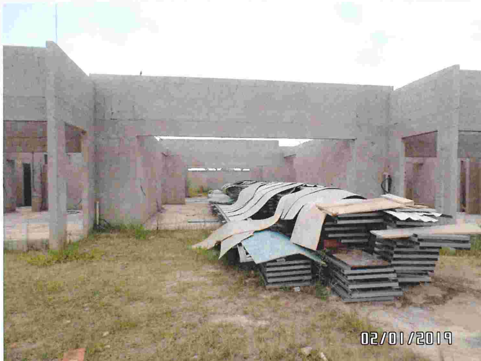
Estrutura da cobertura
