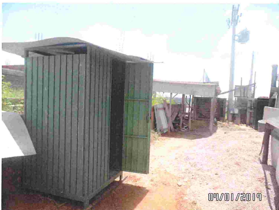
Canteiro limpo e banheiro instalado
