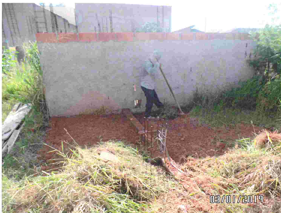
Limpeza da obra
