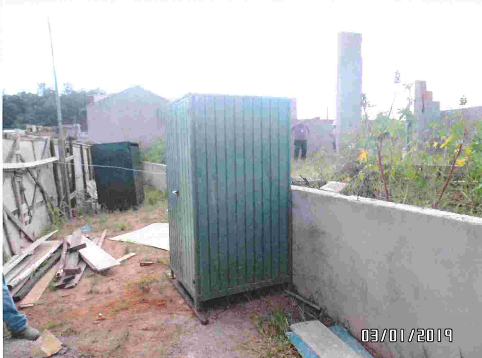
Instalação dos banheiros
