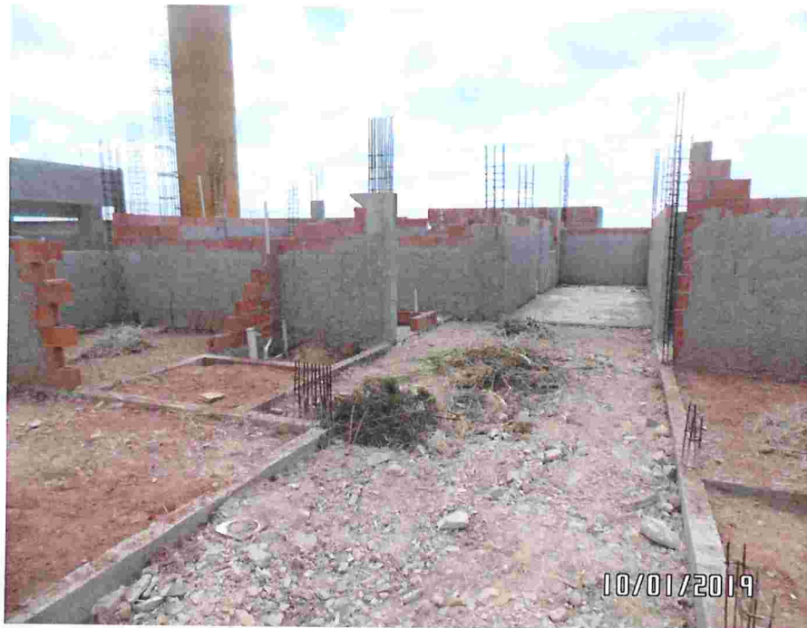
Finalizando a limpeza da obra
