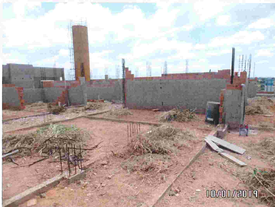
Finalizando a limpeza da obra
