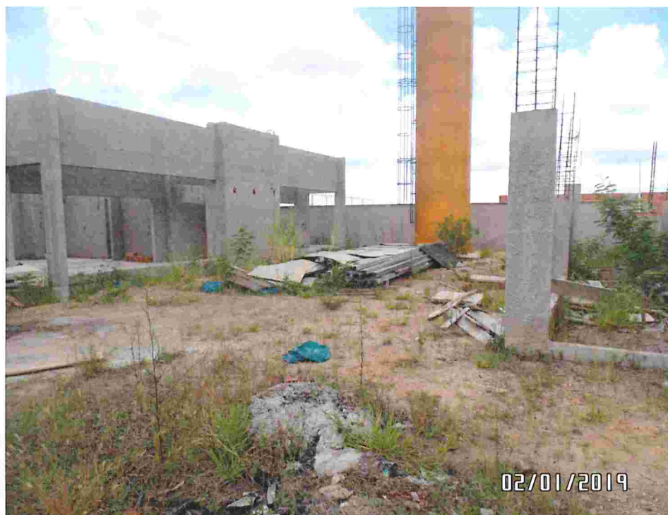
Estrutura da cobertura e a caixa d'água
