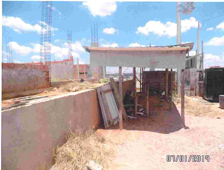
Finalizando a limpeza da obra
