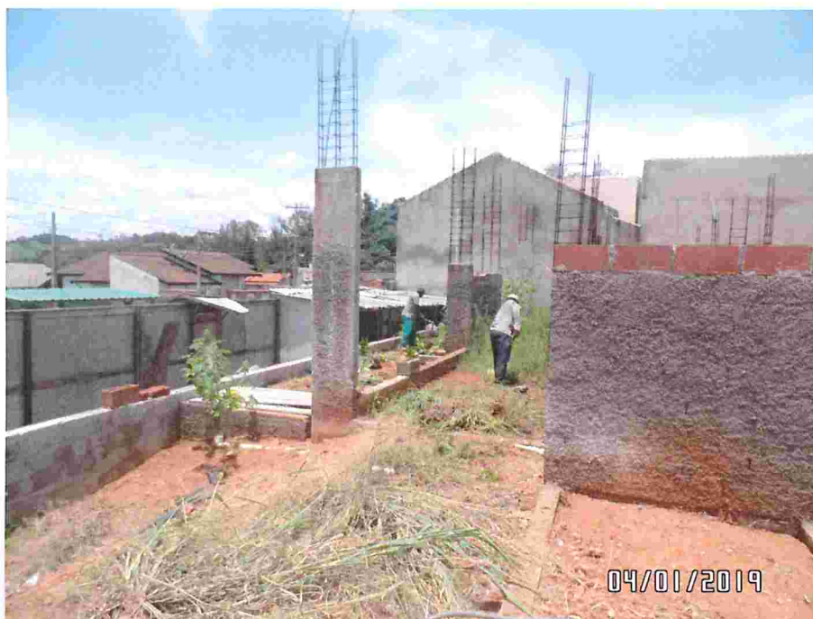
Limpeza da obra
