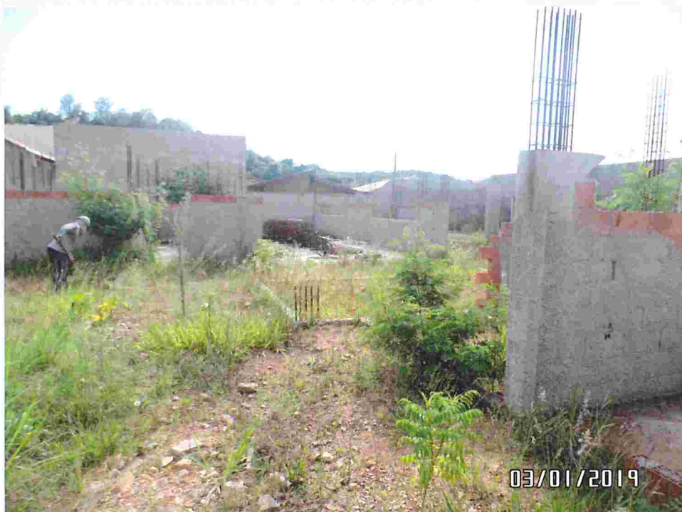
Limpeza da obra
