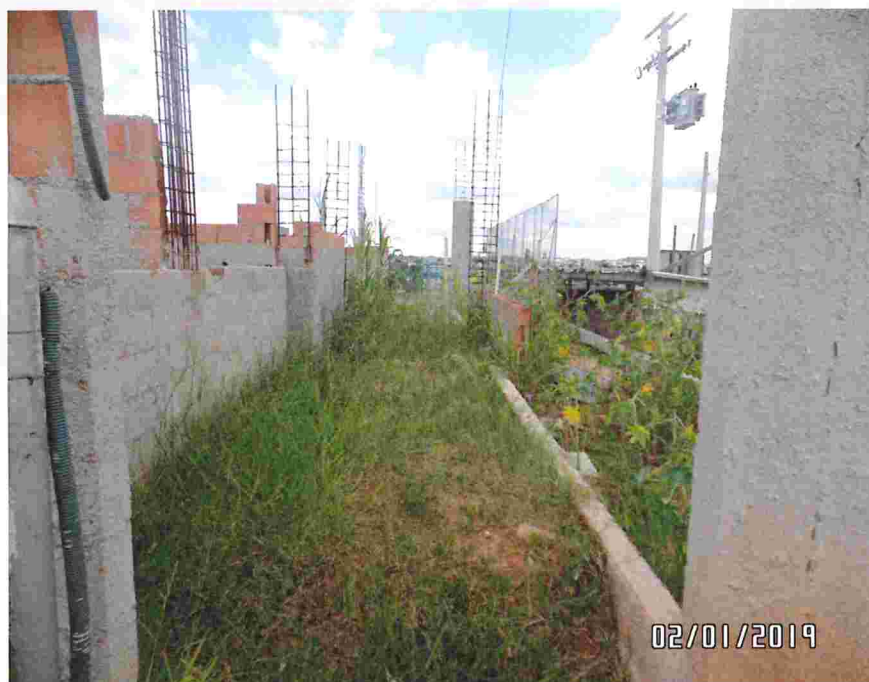
Estado da obra quando da retomada
