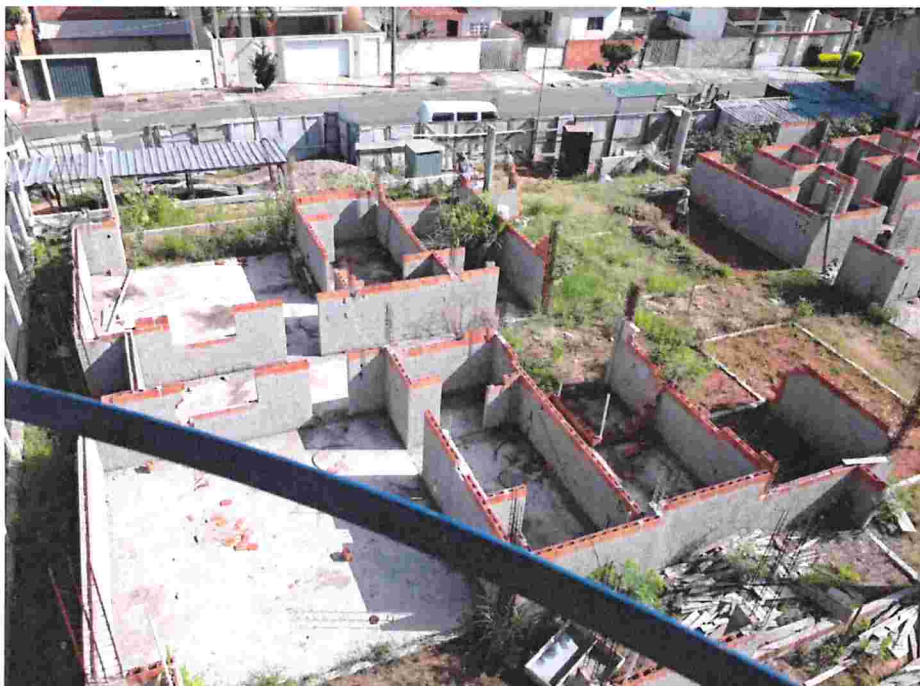
Vista de cima da caixa d'água
