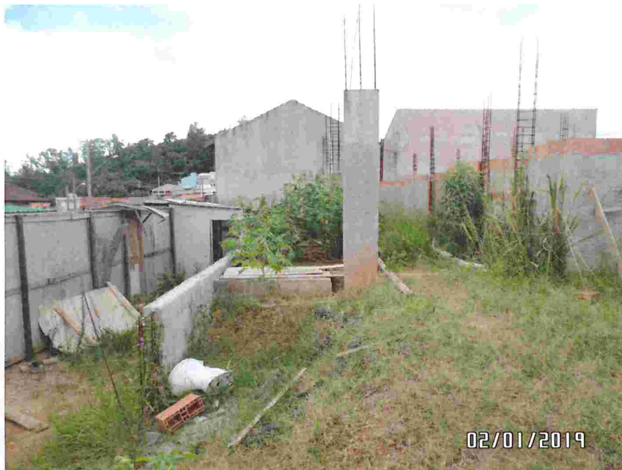
Estado da obra quando da retomada
