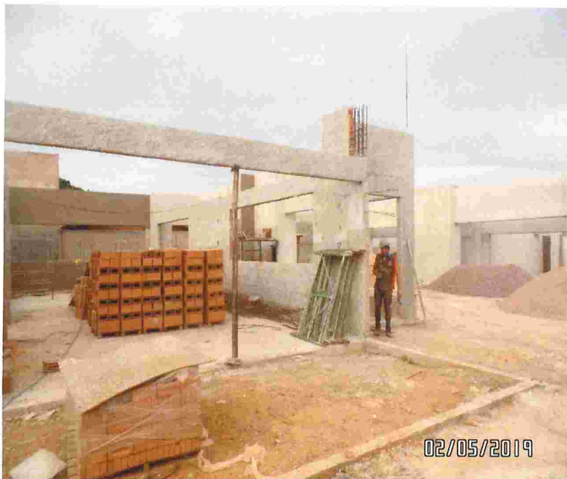
Estado atual da obra
