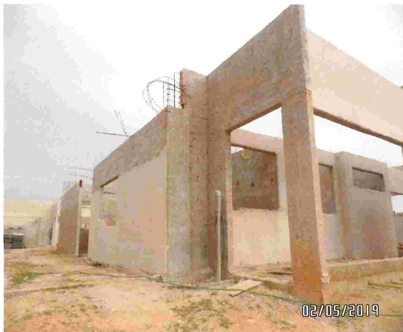
Estado atual da obra
