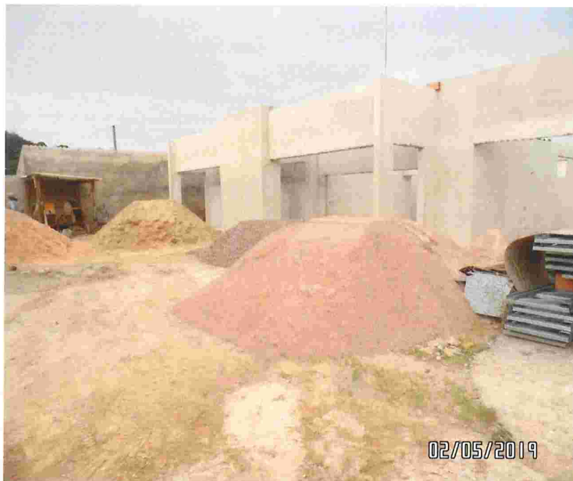
Estado atual da obra
