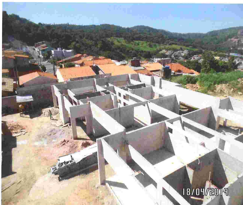
Vista de cima da caixa d'água
