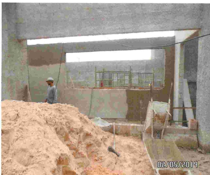
Estado atual da obra
