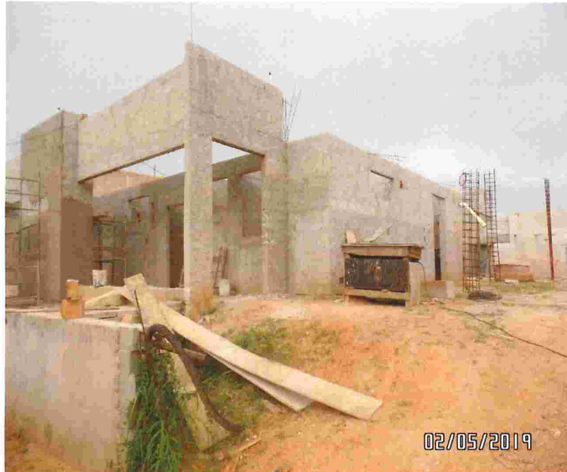
Estado atual da obra
