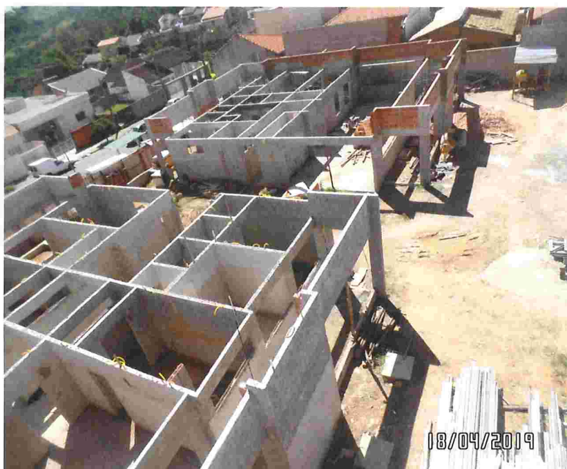
Vista de cima da caixa d'água
