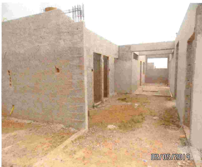
Estado atual da obra
