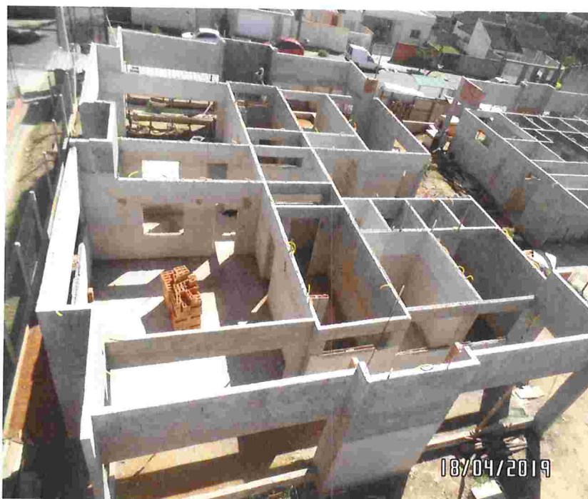
Vista de cima da caixa d'água
