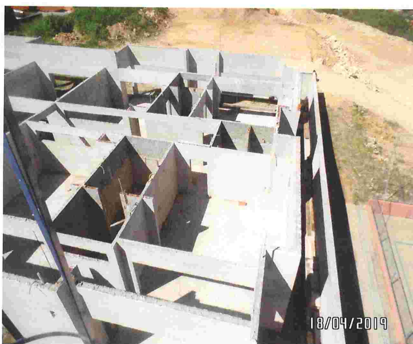
Vista de cima da caixa d'água
