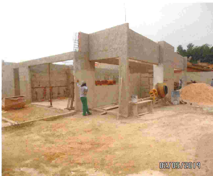
Estado atual da obra
