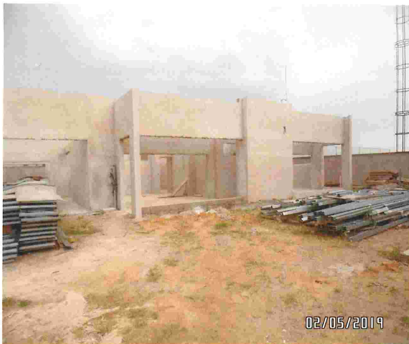
Estado atual da obra
