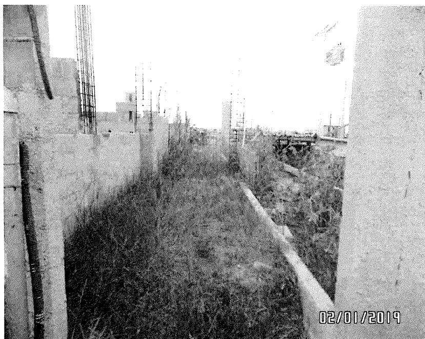
Estado da obra quando da retomada
