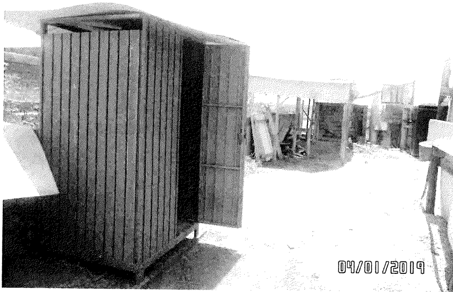
Canteiro limpo e banheiro instalado
