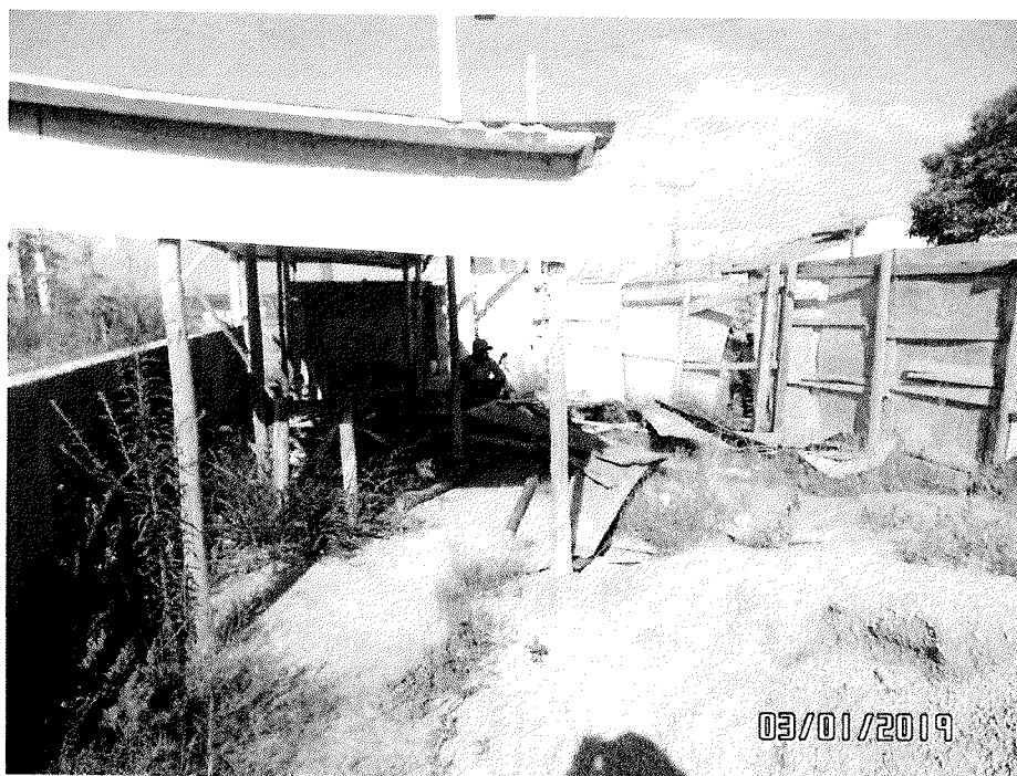
Limpeza da obra - Canteiro
