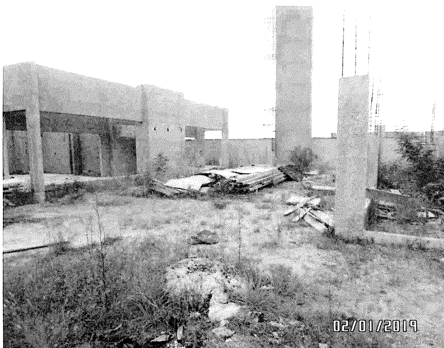
Estrutura da cobertura e a caixa d'água
