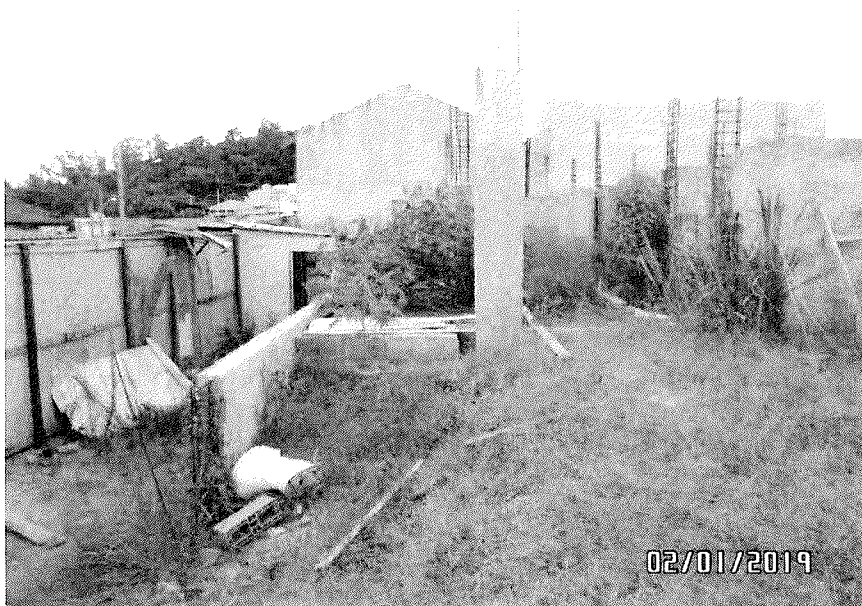
Estado da obra quando da retomada
