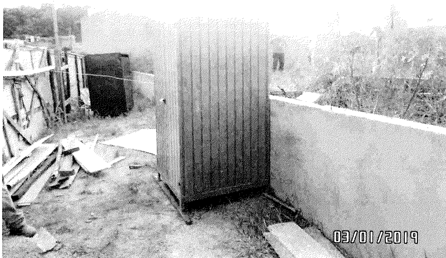
Instalação dos banheiros
